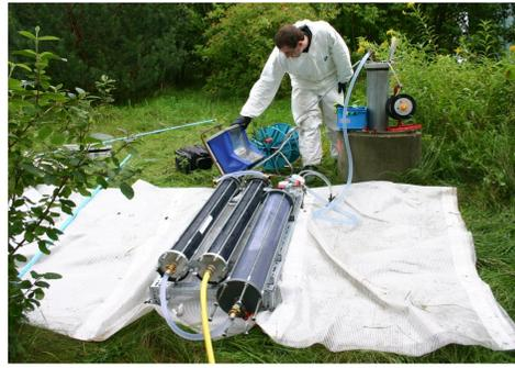
Abpumpmaßnahmen an LHKW-belasteten Grundwässern und Ableitung über eine mobile Aktiv-Kohle Reinigungs-Einheit
